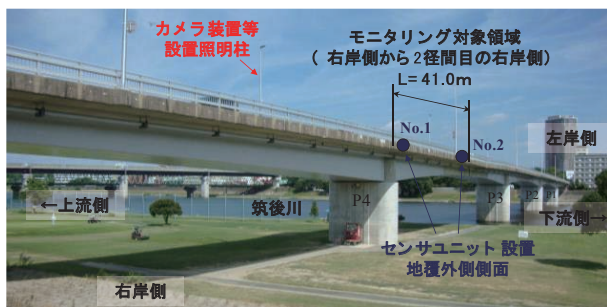
写真-1 長門石橋実証実験エリア(装置配置)
