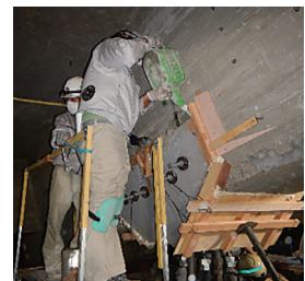
④ グラウト注入
