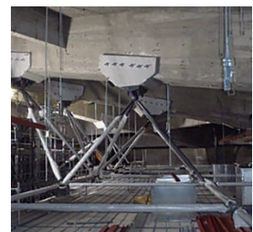
⑥ 上弦トラス施工完了
