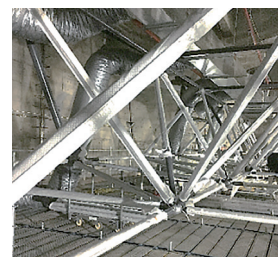
⑧ 下弦トラス取付完了
