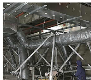
⑦ 下弦トラス取付
