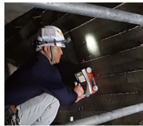
① 鉄筋探査
