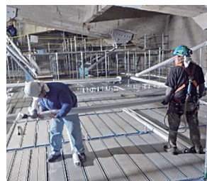
⑤ 上弦トラス取付
