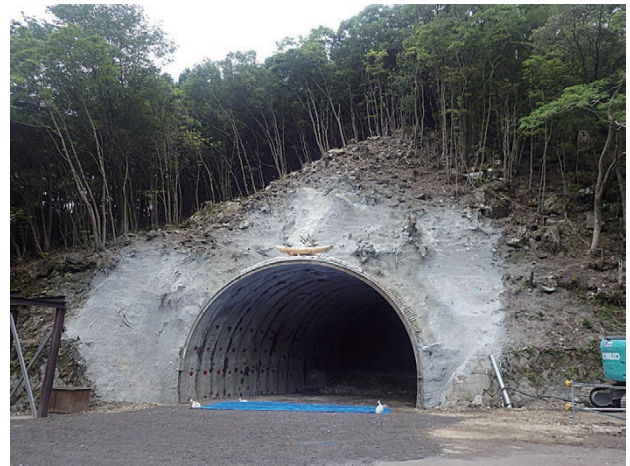
写真一3 坑口付け完了
