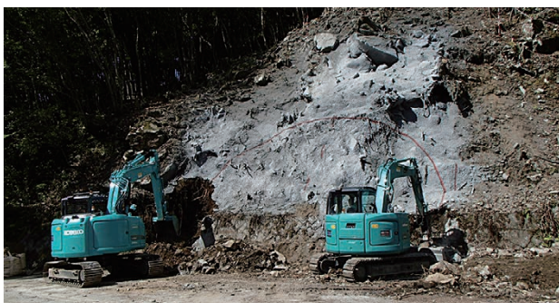
写真一2 転石、浮石除去、法面吹付け完了
