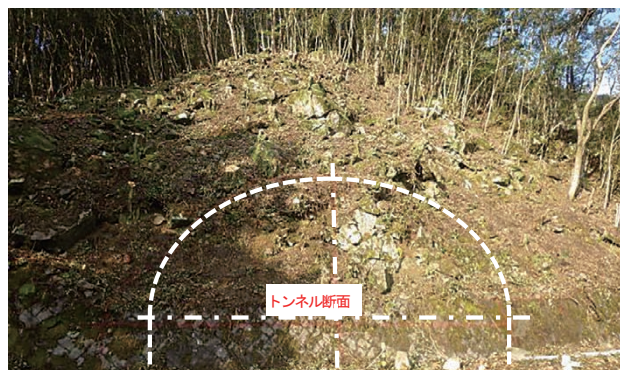
写真一 伐採後の坑口部状況
