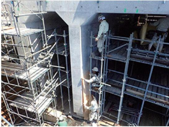
写真一 貼付型養生シートの設置状況
