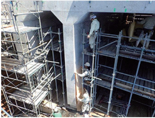
写真一 貼付型養生シートの設置状況
