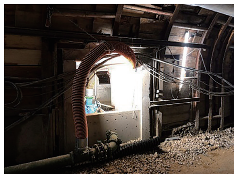
写真－5 導水迂回坑完成
