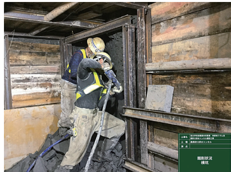
写真－3 導水迂回坑掘削状況
