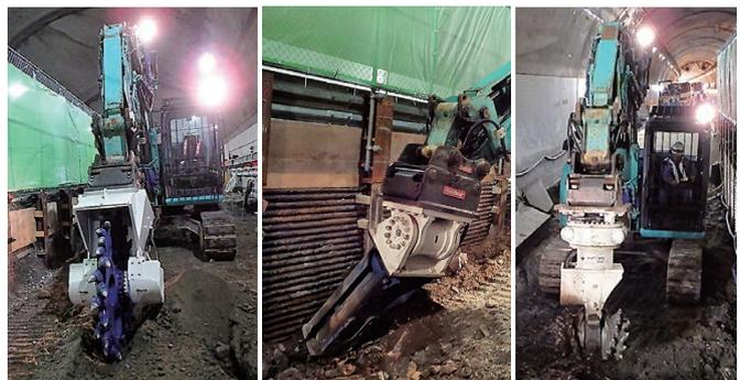
写真-2 多機能型掘削機械による掘削状況
