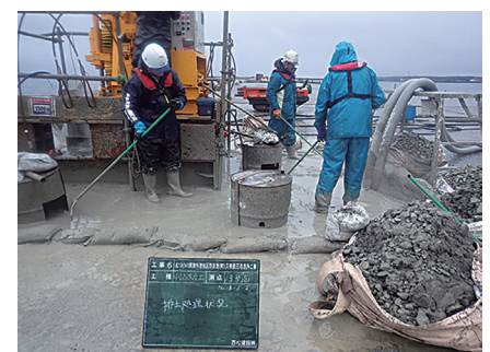
写真-1 ケーソン上での排泥処理
