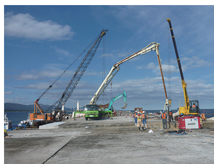
写真-3 打設状況全景
