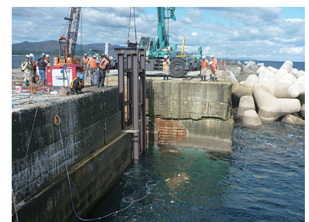
写真-4 波除鋼材設置状況
