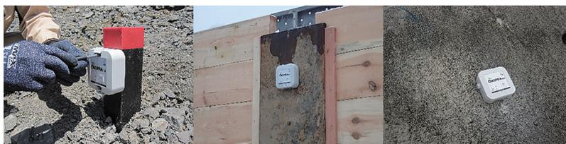
写真一 傾斜監視クラウドシステム OKIPPA104 の設置状況
