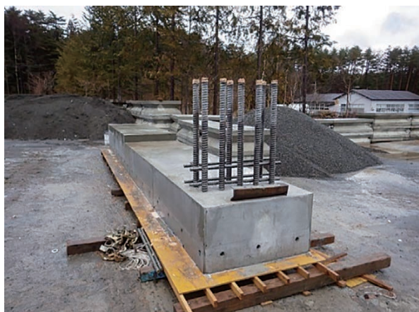
写真二 充填確認
