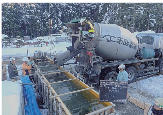
写真一 試験施工状況
