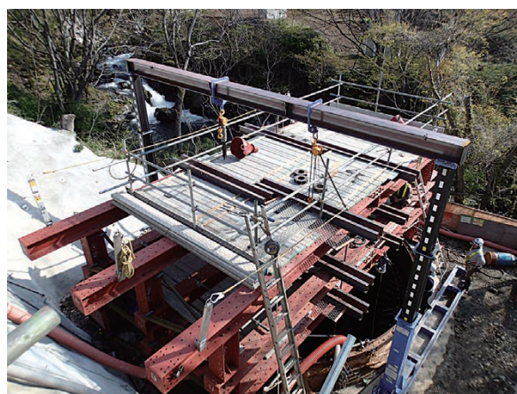
写真三 コンクリート打設架台
