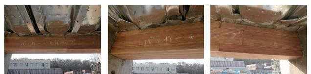
写真-4 c. 角バッカーの水切り
