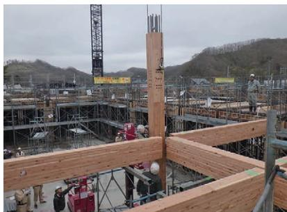
写真-9 木構造柱建込み状況
