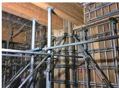
写真-16 木構造内部RC取合状況
