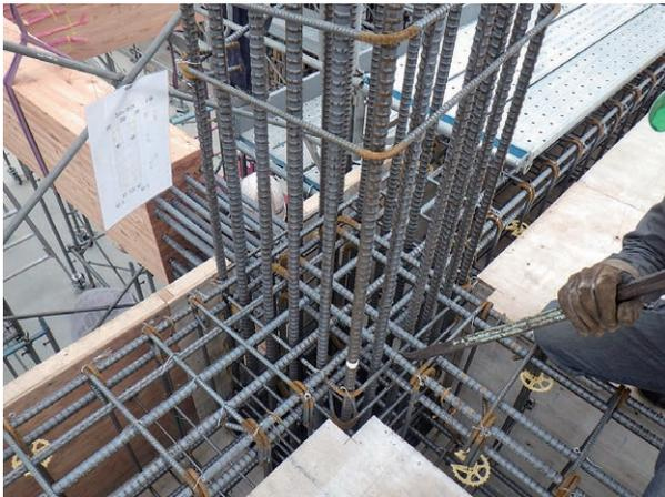
写真-17 木構造梁差し込み状況
