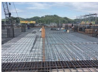
写真-15 木構造部スラブ配筋状況
