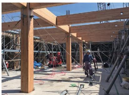
写真-11 木構造建入れ調整状況
