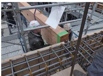
写真-7 木構造梁架設状況
