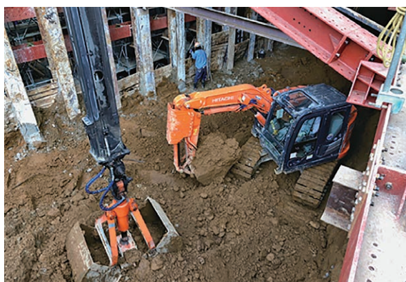
写真一12 後行工区の掘削状況-1
