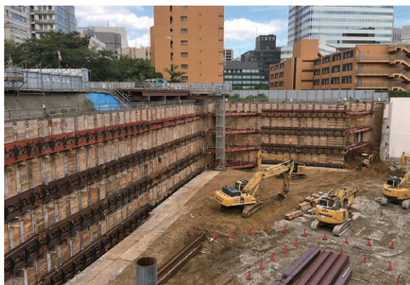
写真一10 先行工区の掘削状況
