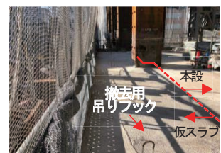
写真-7 仮スラブ
