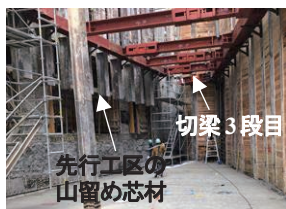
写真一8 先行工区の山留め芯材の切断（床付け後）
