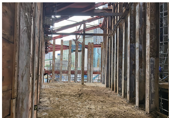
写真一13 後行工区の掘削状況-2
