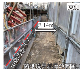
写真-1 山留め背面の状況
