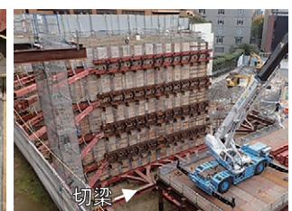
写真-3 東面の先行工区の支保工
