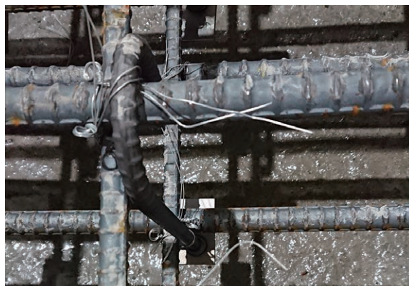
写真一1 Head-bar 設置状況
