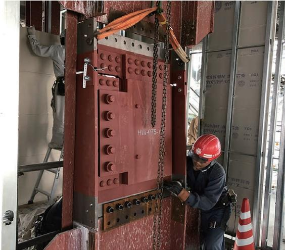
写真-5 取付間柱とダンパーの接合状況
