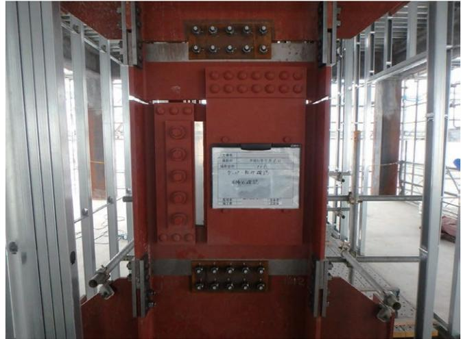
写真-6 ダンパー本締め完了
