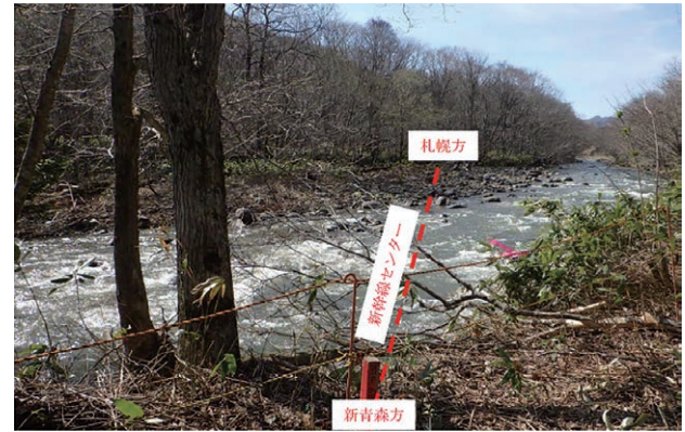
写真-1 トンネル直上現況
