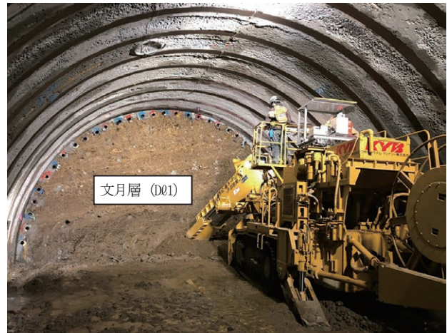
写真-2 掘削状況写真
