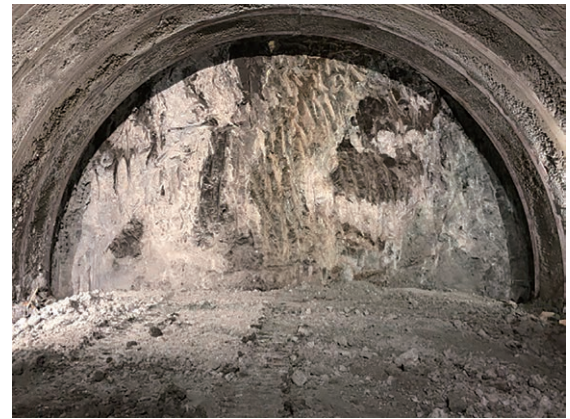
写真-5 切羽写真 (155 km 694 m)
