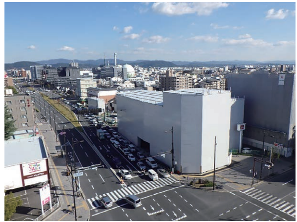
写真-1 防音ハウス全景
