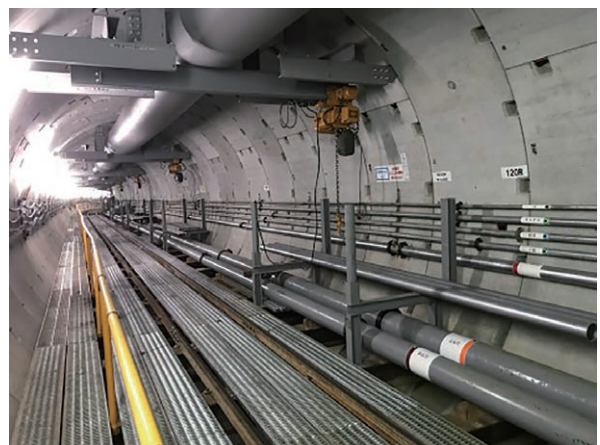
写真-2 坑内資材置場
