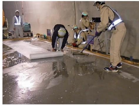
写真一 給水養生用シート敷設状況
