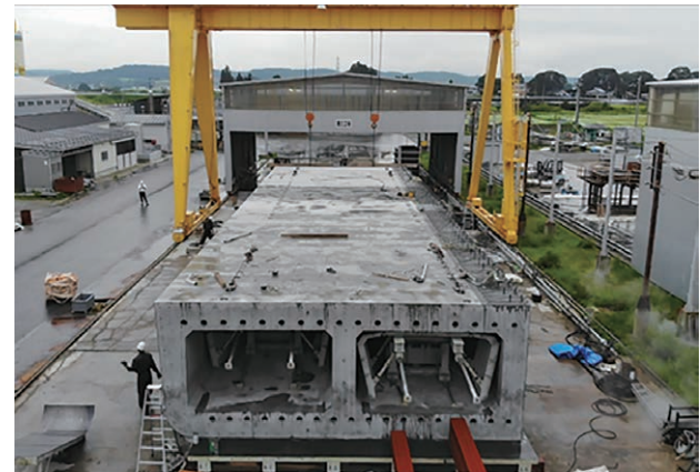
写真－1 セグメント製作状況
