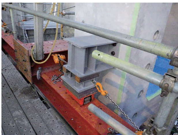
写真-4 横移動装置
