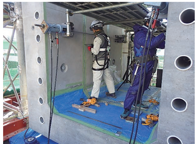
写真-2 引き寄せ状況
