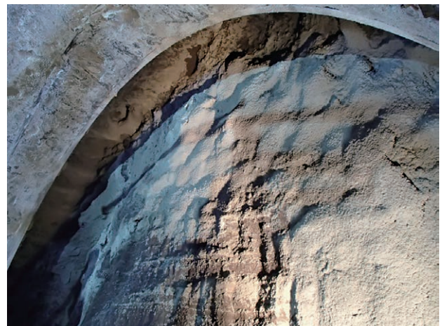
写真一2 TD=168 m 天端崩落
