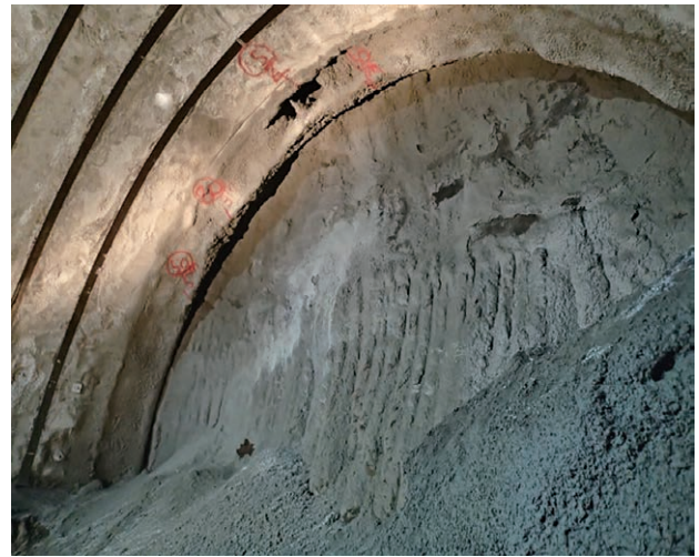
写真一1 TD=102 m 天端崩落
