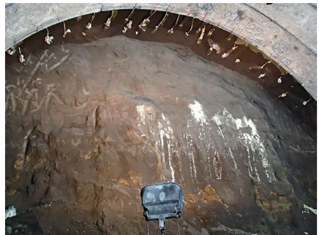
写真一3 TD=413 m 天端崩落
