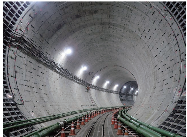
写真-5 切削セグメント坑内状況
