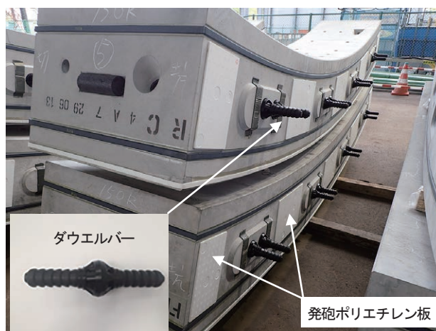
写真-2 リング継手構造の外観 (部分ほぞ+ガラス繊維強化樹脂製ダウエルバー)
