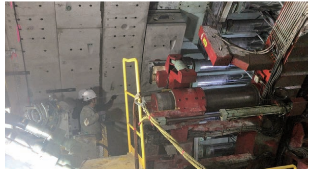
写真-4 切削セグメント組立状況
