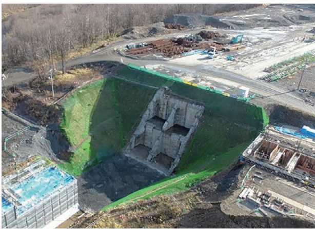
写真-1 箱型 RC 地中連続壁完成写真
