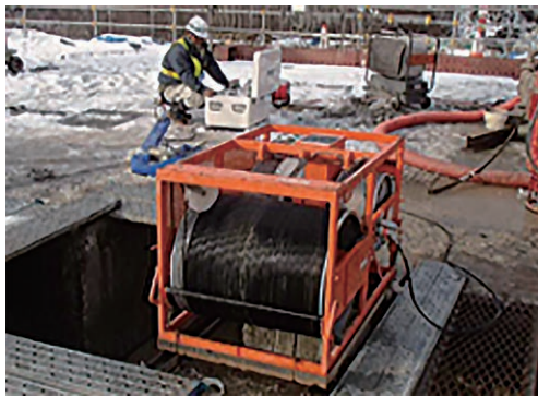
写真-3 超音波溝壁測定器
