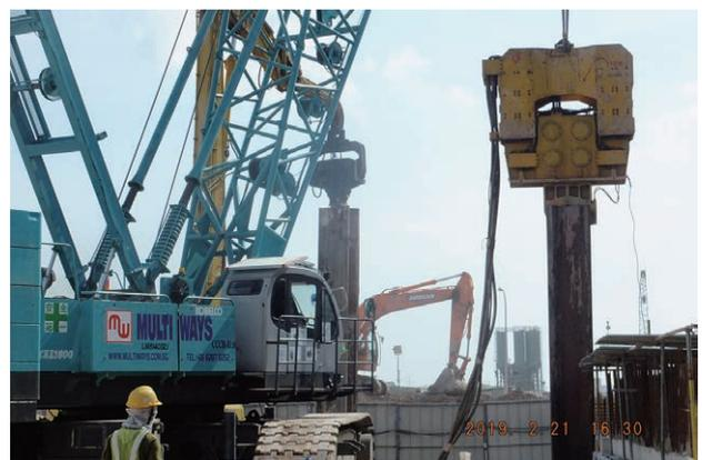
写真-3 土留め壁引抜き状況
