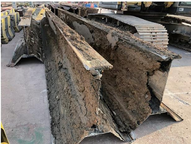
写真-5 土砂付着状況
