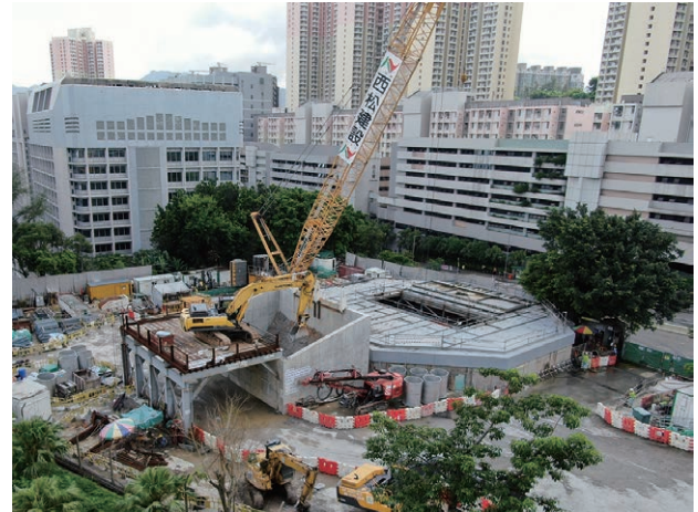
写真-5 立坑掘削坑外仮設備全景（岩盤掘削時）
