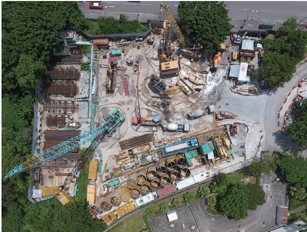
写真-4 連続地中壁施工状況（ポンプ打設時）
