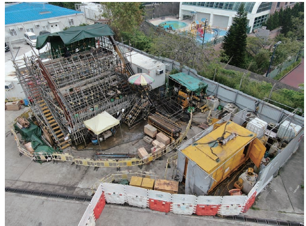
写真-7 ボーリング状況（削孔機は構台右端）
