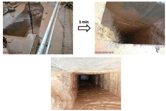
写真-1 逸泥状況写真
