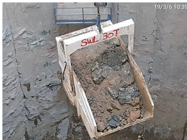
写真-3 固化グラウト (青黒い部分)
