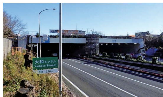
写真一7 拡幅後全景
