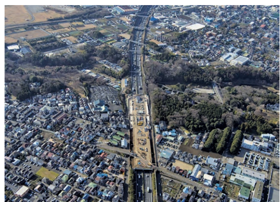
写真一2 大和トンネル付近の全景
