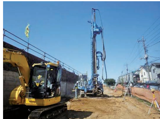
写真-4 地盤改良工の施工状況
