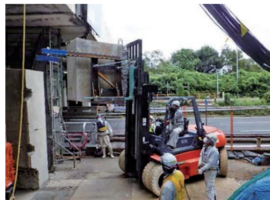
写真-6 ブロック取出し状況
