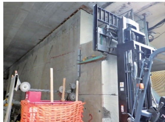
写真-5 乾式ワイヤーソー
