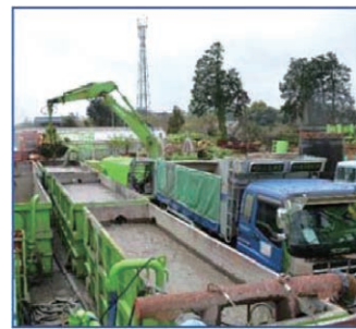
JSHR拡底掘削状況
