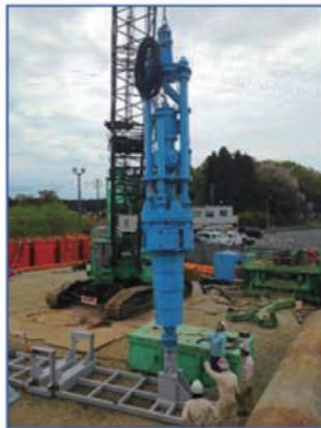
JSHRリバー式掘削機
