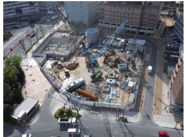
写真-1 施工状況
