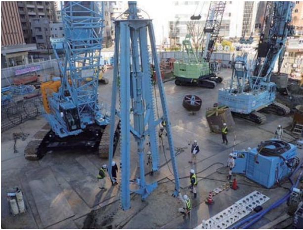
写真-4 拡底部ビット
