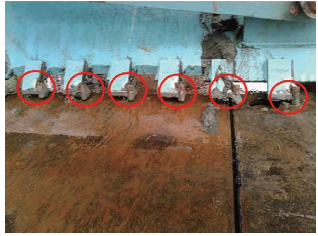
写真-5 拡底ビット改善状況
