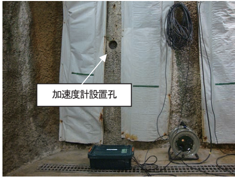
写真一9 125 m 計測横坑北側壁に設置した受信点⑥
