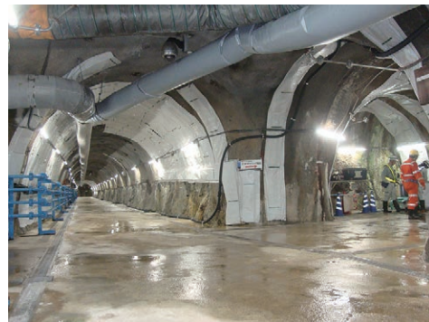
写真-7 研究アクセス南坑道(左)と20mボーリング横坑(右)
