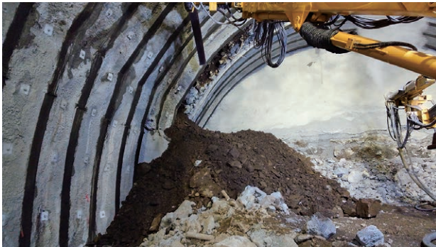
写真-2 切羽左肩部における土砂流出状況
