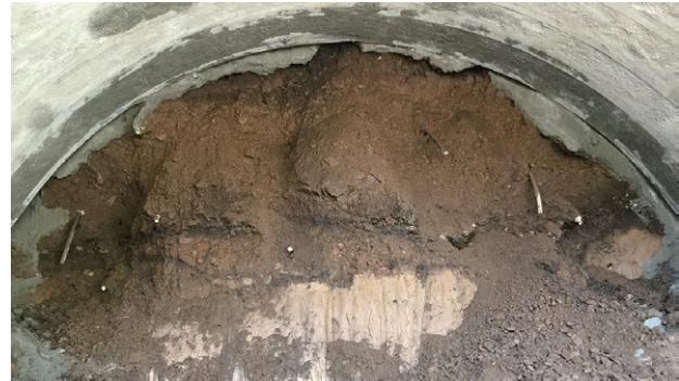
写真-1 岩屑流堆積物が出現した坑口部
