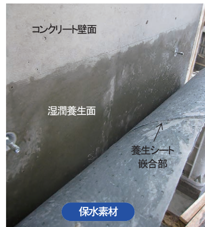
写真-3 壁面の湿潤状況
