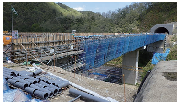
写真一 橋梁での現場試験測定
