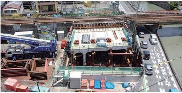
写真一 1 函体構築完了（第 1 工程）
