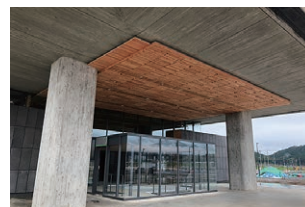
写真一八 1階柱全景
