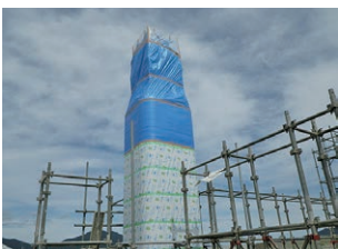
写真一五 養生状況
