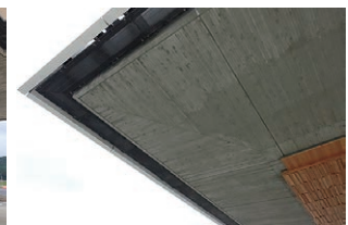
写真一九 軒天仕上り状況
