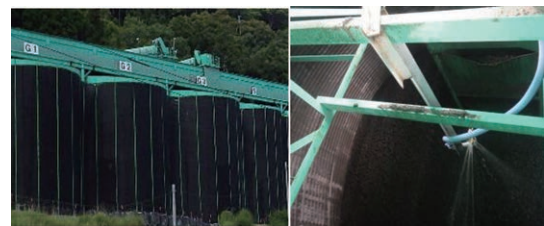
写真-1 打込み温度低減対策 （左：寒冷紗による日よけ、右：冷水の散水）
