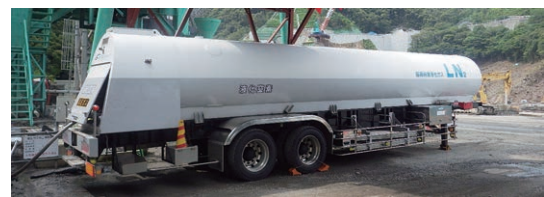
写真-2 LN2供給設備（タンクローリー）
