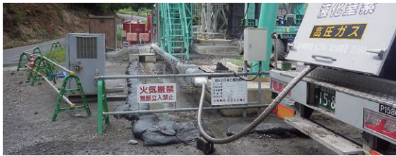
写真-3 簡易断熱配管
