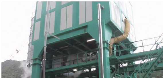
写真-5 バッチャープラント排気式換気対策
