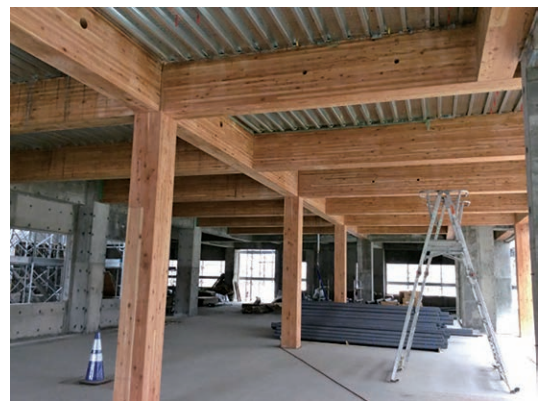
写真-3 内部 RC 型枠解体状況
