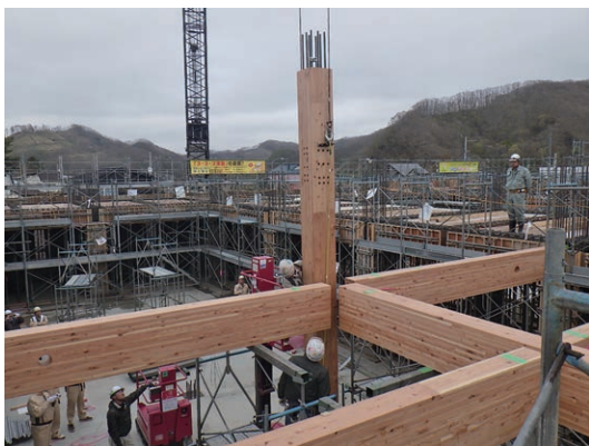
写真-1 木構造柱建込み状況
