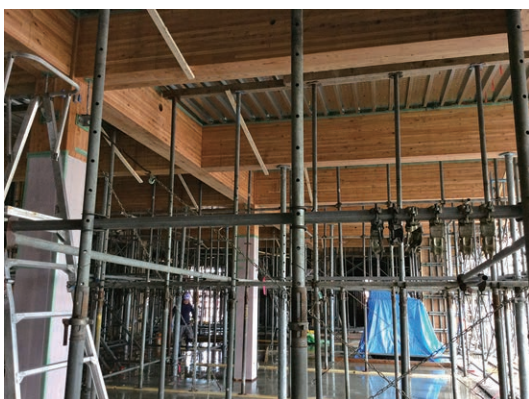
写真-2 木構造見え掛かり部打設中
