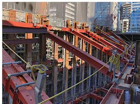
写真一1 1段目支保工架設状況
