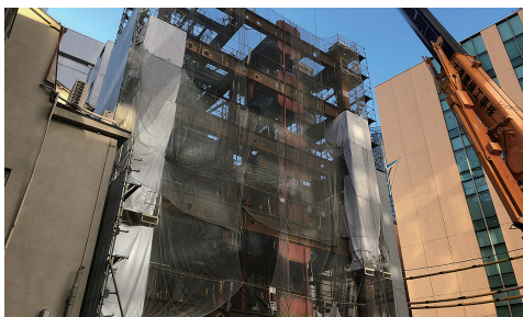
写真-1 鉄骨建方状況
