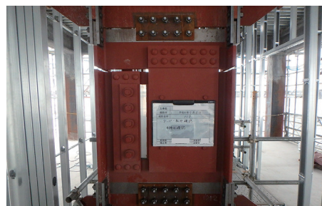
写真-2 ダンパー設置状況
