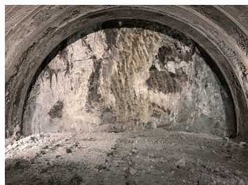
写真－1 変状区間切羽写真
