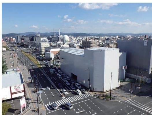
写真-1 防音ハウス全景
