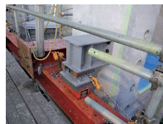
写真-2 横移動装置
