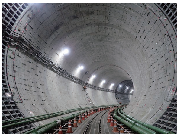
写真-2 切削セグメント坑内状況
