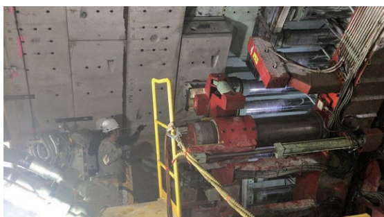
写真-3 切削セグメント組立状況
