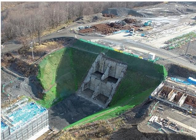
図一 箱型 RC 地中連続壁完成写真
