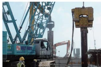
図-4 土留め壁施工状況
