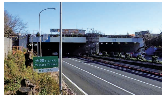
写真－2 拡幅後全景
