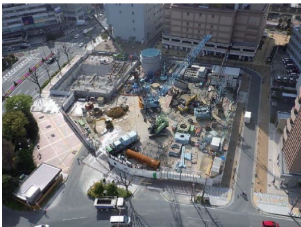
写真－1 施工状況
