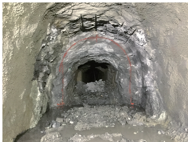
写真-1 切羽状況
