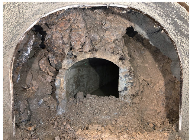
写真一3 覆工区間の切羽状況（坑口より1390 m付近）
