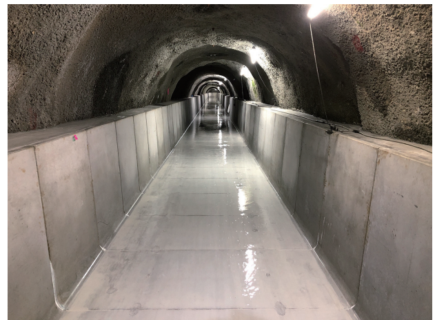
写真-4 水路設置完了
