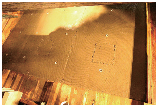
写真－10 脱型直後のコンクリート表面
