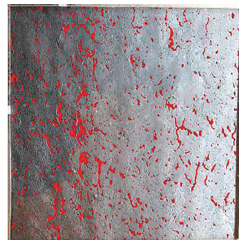
写真一4 気泡発生状況（A部）
