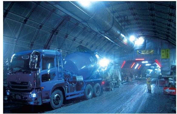
写真-8 覆工コンクリートの施工状況
