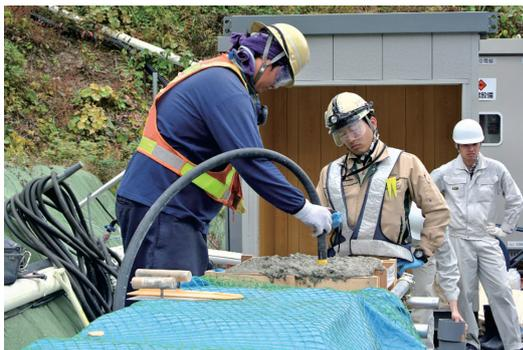
写真-5 圧送後の締固め状況
