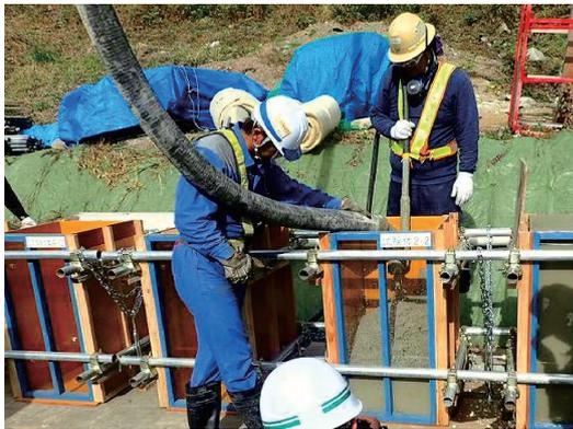
写真-4 ポンプ車による圧送打ち込み状況
