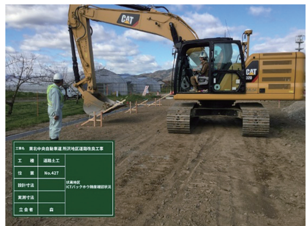
写真-8 バックホウMG位置確認状況
