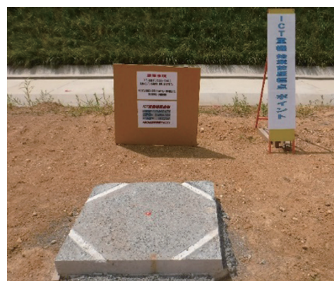
写真-9 ICT建機用基準点
