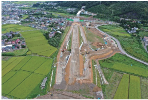
写真一2 盛土区間（伏黒地区）
