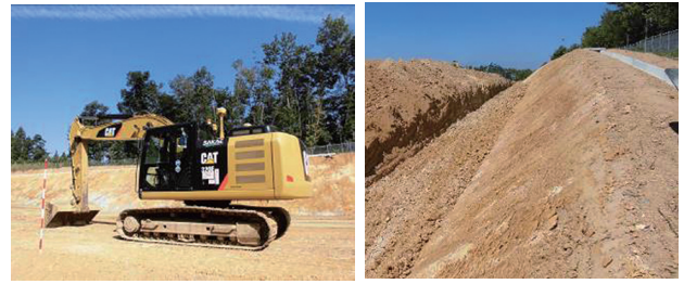
写真-5 バックホウ MG と丁張りレスの施工状況
