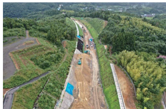
写真－1 切土区間（保原地区）
