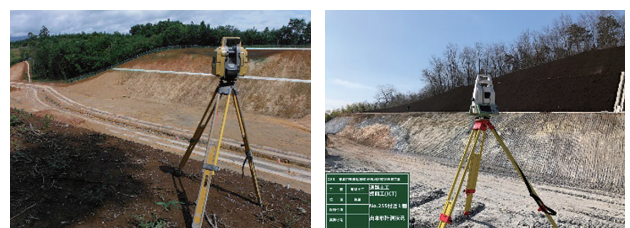
写真-6 レーザースキャナによる出来形計測状況
