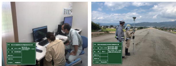
写真-7 出来形検査状況
