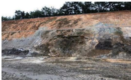
写真-3 法面崩壊の状況
