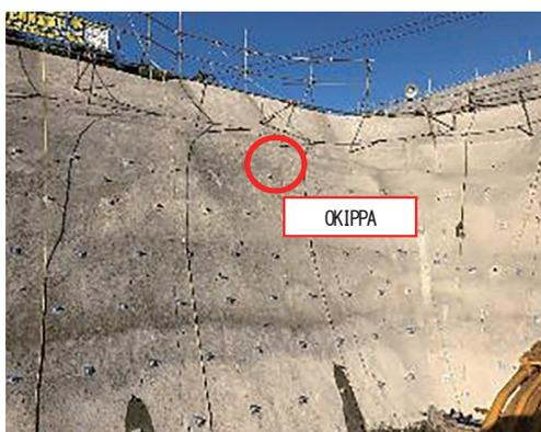
写真—7 切土法面の監視事例
