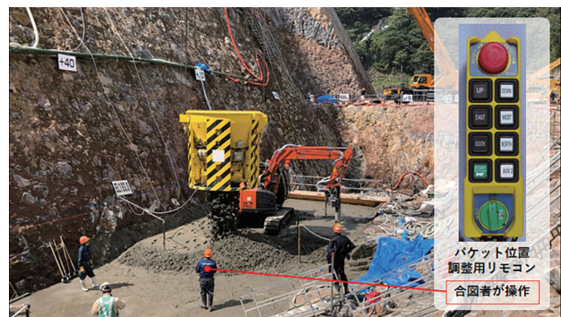
写真-10 自動運転によるコンクリート打設
