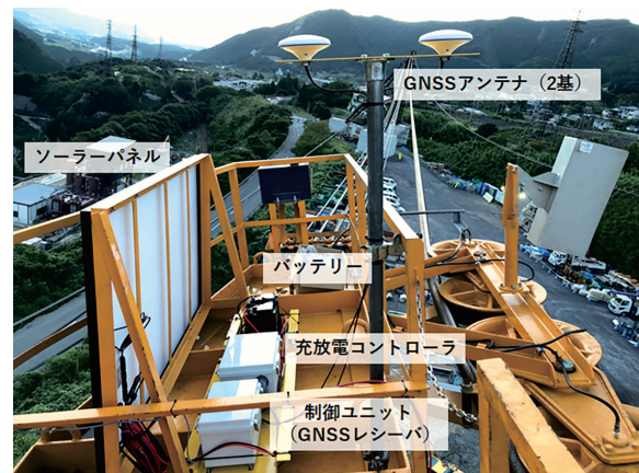
写真-4 GNSS 受信装置 (走行トロリ)
