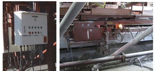
写真-12 剥離剤塗布内蔵ベルト式自動ケレンシステム
