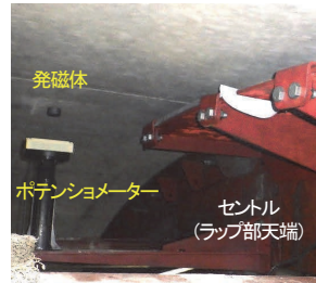
写真-4 天端誘導装置
