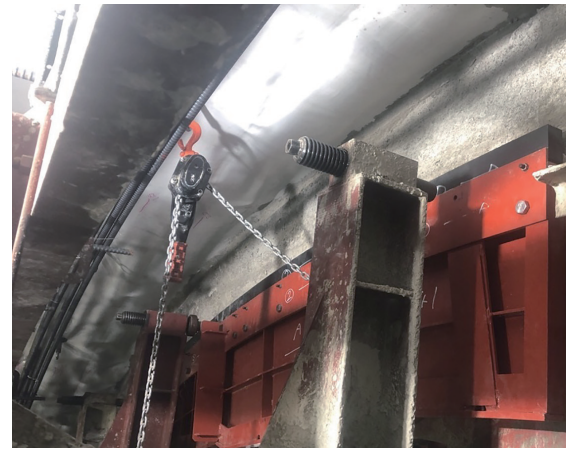
写真-14 鋼製妻板の改造 (硬質スポンジタイプ)
