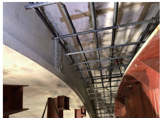
写真-13 鋼製妻板を用いた妻面の仕上り
