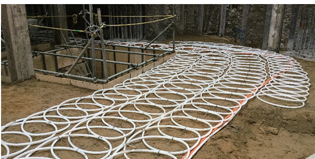
写真二 地中熱交換器の敷設状況
