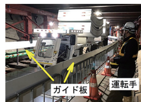
図-6 自動誘導状況
